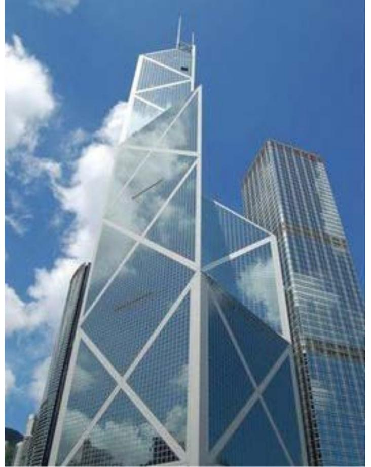
整座大楼采用由八片平面支撑和五根型钢混凝土柱所组成的混合结构“大型立体支撑体系”，此一混凝土—钢结构立体支撑体系，在改进结构性能方面具有如下独到之处：
