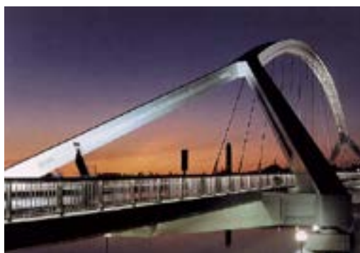
1992 年塞维利亚世博会建造的阿拉 米罗大桥
